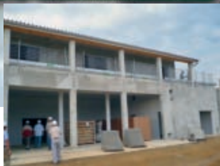
Station d'épuration, septembre 2008
