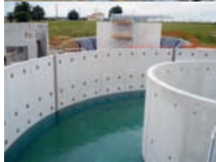
Avancement des travaux de la station d'épuration
