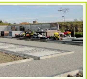
ouverture, dans les poutres, due à des infiltrations d'eau
