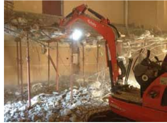
démolition du balcon
