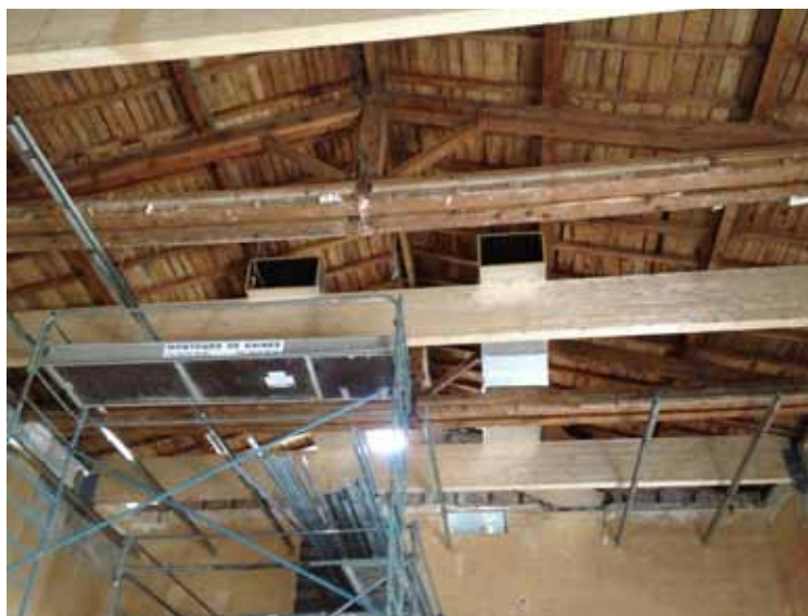
renforcement de la charpente
